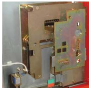
Enclavamientos que impiden la conexión del seccionador de tierra cuando está cerrado el interruptor y al revés, imposibilidad de cerrar el interruptor si está cerrado el seccionador de tierra.
