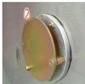
Membrana de seguridad que, en el caso de defectos por arco interno, liberan los gases originados en una dirección que impide daños a las personas que pueden estar maniobrando la celda.
