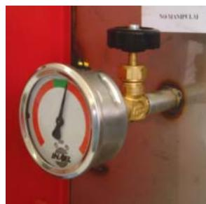
Manómetro con válvula de bloqueo (uno en cada función modular o uno por celda compacta).
