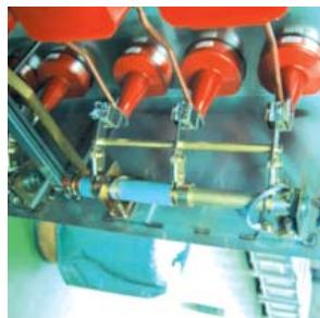
Seccionador de puesta a tierra. Este seccionador es doble y, cuando se cierra, pone a tierra ambos extremos de los fusibles. Su eje de accionamiento está debajo del eje de accionamiento del interruptor-seccionador.
