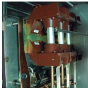
Los aisladores de los interruptores-seccionadores de las celdas de línea y protección van montados sobre una placa metálica unida rígidamente al chasis, por lo que cualquier corriente de fuga deriva directamente a tierra.
