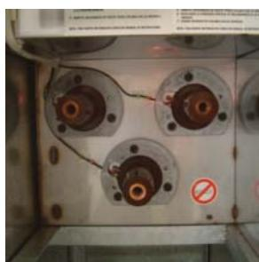
Entrada de cables mediante conectores enchufables o atornillables, de 400 A ó 630 A, según especificaciones del cliente. Normalmente se suministra con pasatapas de 630 A que alojan conectores en T. En nuestras funciones de línea inundables no se puede entrar con botellas terminales.
