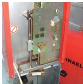
Mecanismo que permite realizar la prueba de cables.
