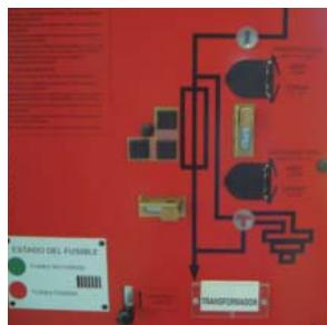
Señalización de fusible fundido o en funcionamiento, mediante color rojo o verde.
