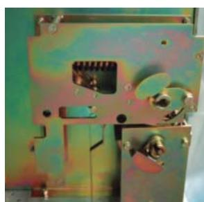
Interruptor seccionador de 400 A, con mando individual que acumula energía durante la operación de cierre para poder abrir, posteriormente, de forma automática, y que puede ser accionada por:
