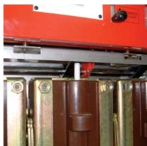
Sistema de disparo del interruptor-seccionador por fusión de un fusible.
